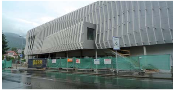
Abb. 7: Generalsanierung Hörsaalgebäude Montanuniversität, Leoben, 2008– Foto: Archiv Architekten
